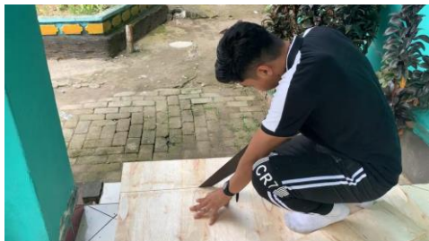
Gambar 5. Proses pemotongan triplek
